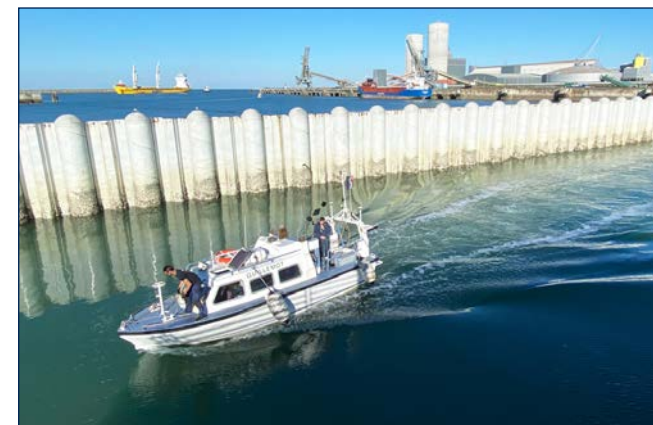
Levé au profit du parc éolien de l'appel d'offres n°7 – La Rochelle
