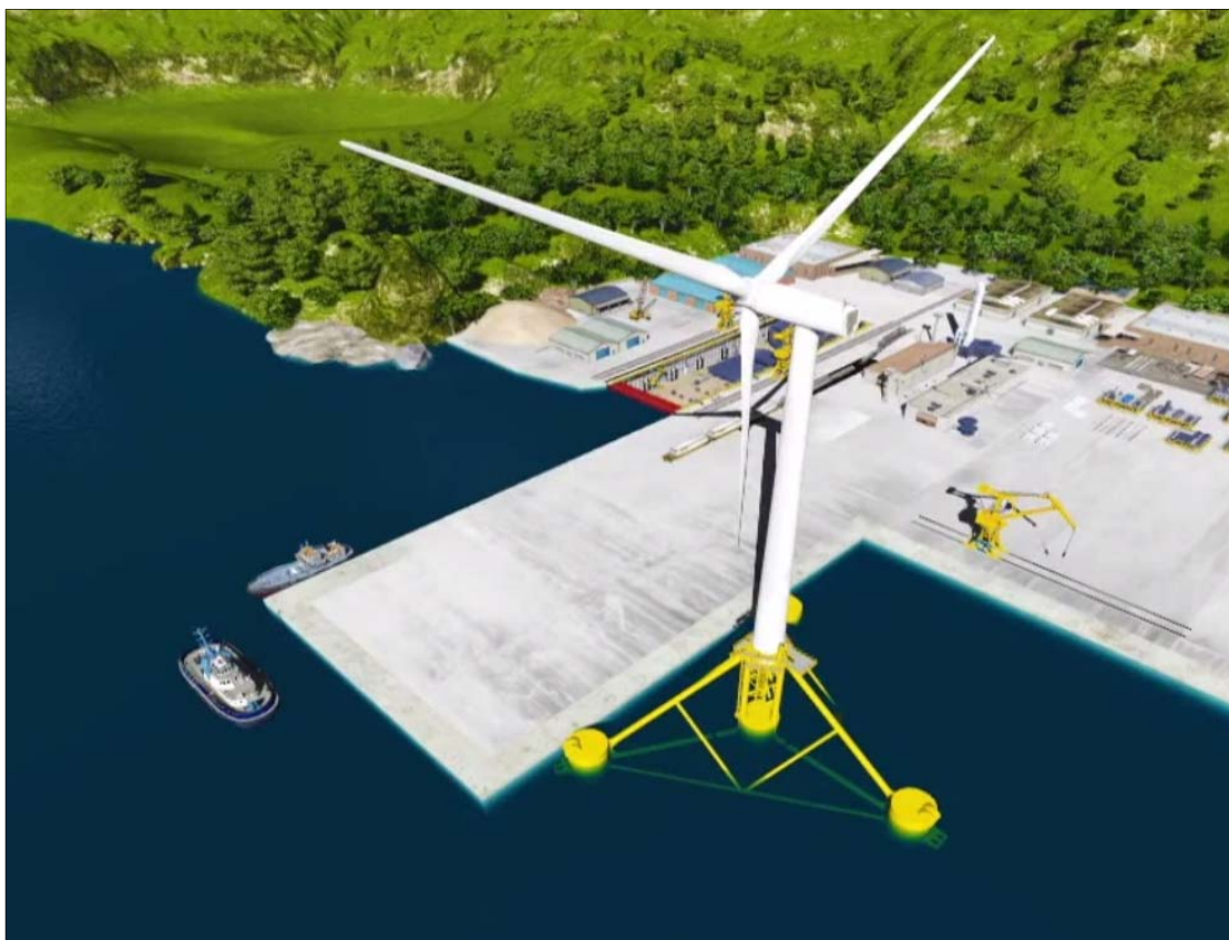
Figure 25 : Illustration de l'éolienne montée sur le flotteur bord à quai (© SBM Offshore)
