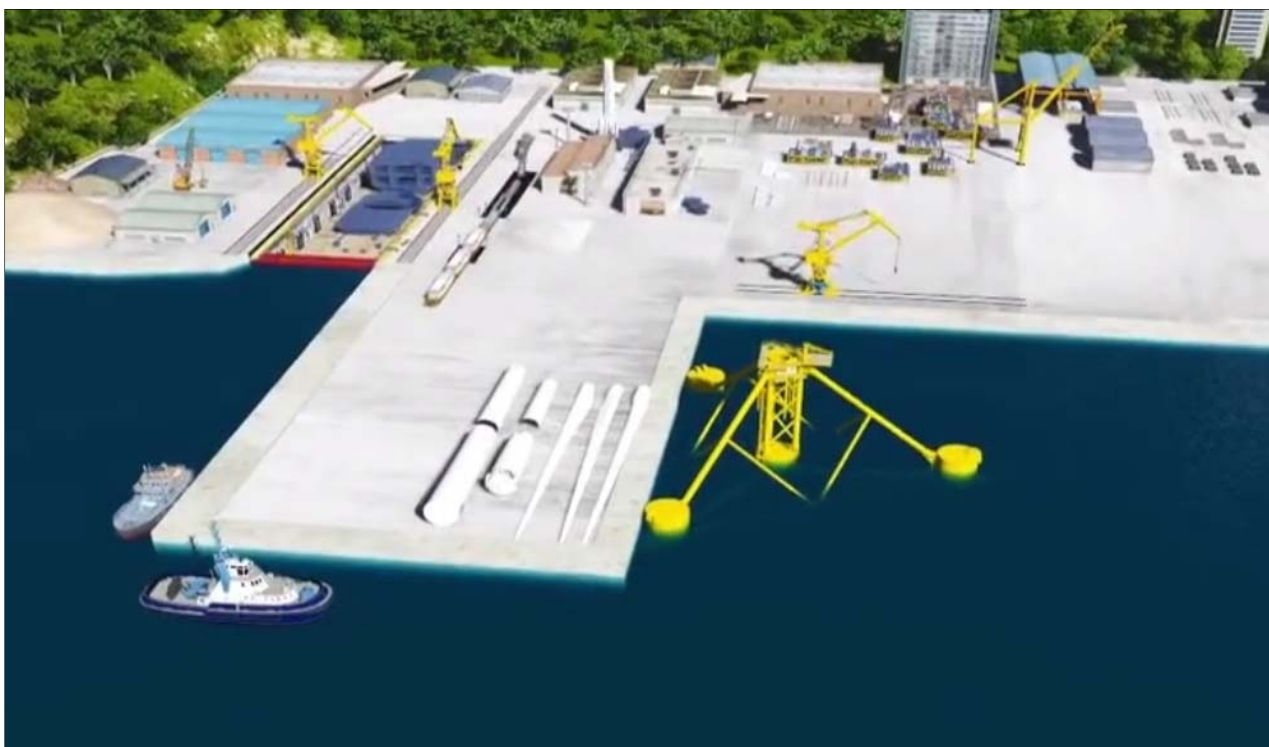
Figure 22 : Illustration de l'intégration de l'éolienne sur le flotteur bord à quai (© SBM Offshore)
