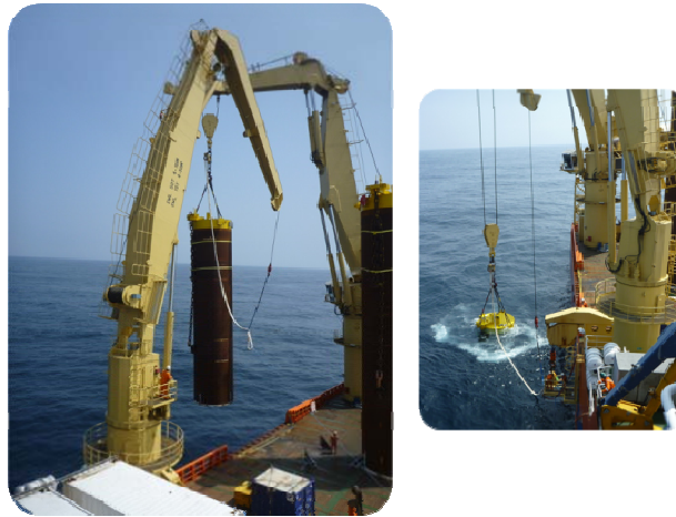
Figure 30 : Mise à l'eau des ancrs
