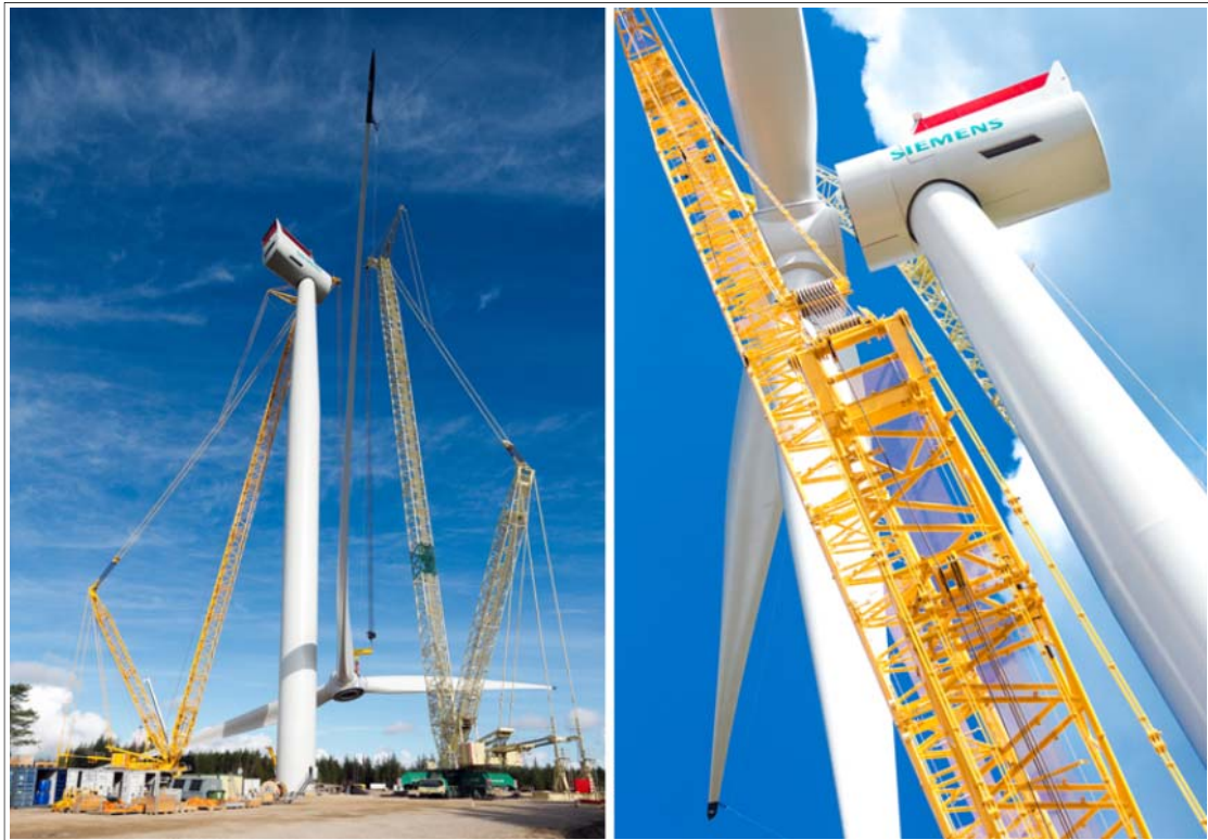
Figure 24 : Illustration de l'opération de levage du rotor complet d'une éolienne (© Siemens)
