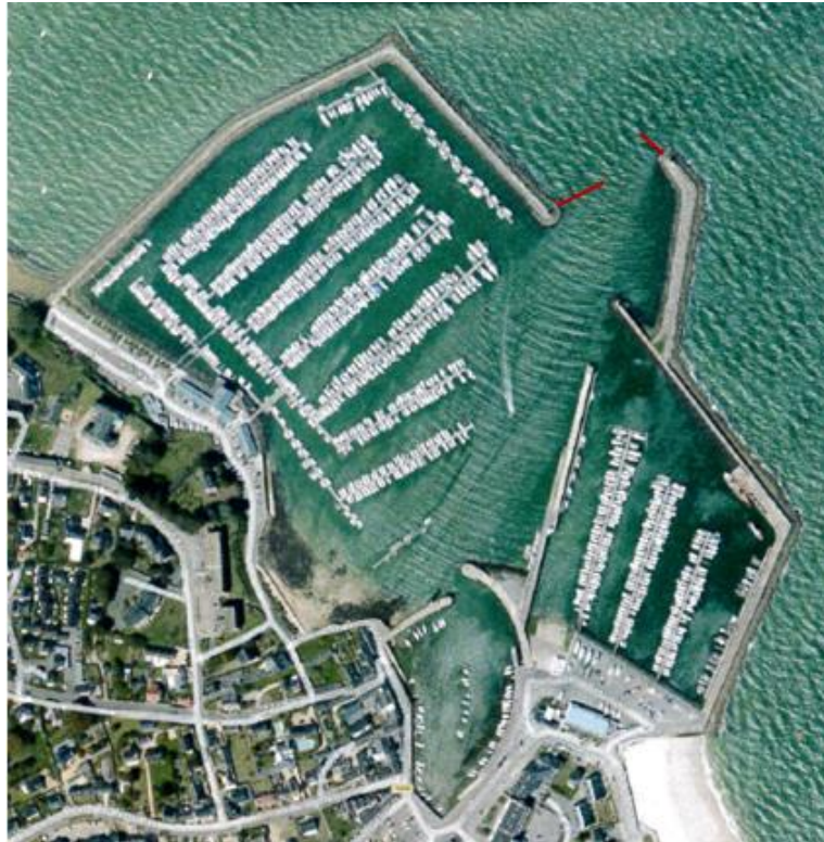
Port Haliguen et positionnement des épis déflecteurs en rouge
