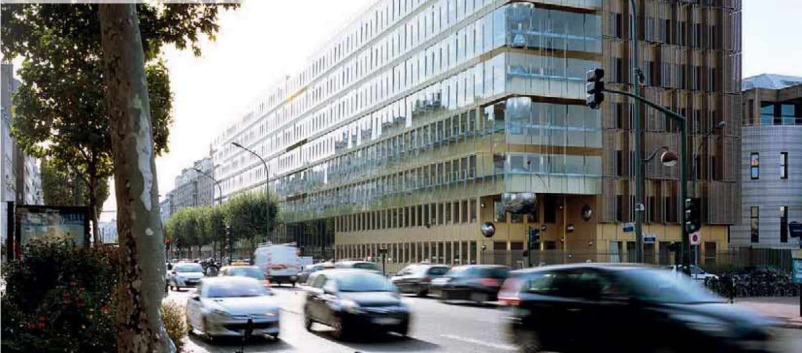
Nouveau bâtiment Pôle Géosciences géographie, hydro-océanographie, météorologie abritant l'antenne du SHOM de Saint-Mandé
