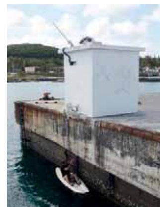
Maintien en condition opérationnelle du capteur de pression du marégraphe côtier numérique (MCN) de Maré
