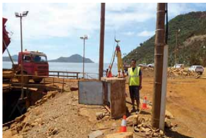
Station GPS de référence : site de chargement du minerai dans la baie de Nakéty
