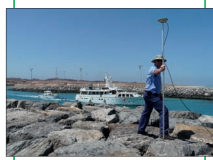
Travaux de spatiopréparation sur l'île de Sir Abū Nu'ayr
