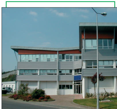
Les bâtiments des missions MHA et MOA à Brest
